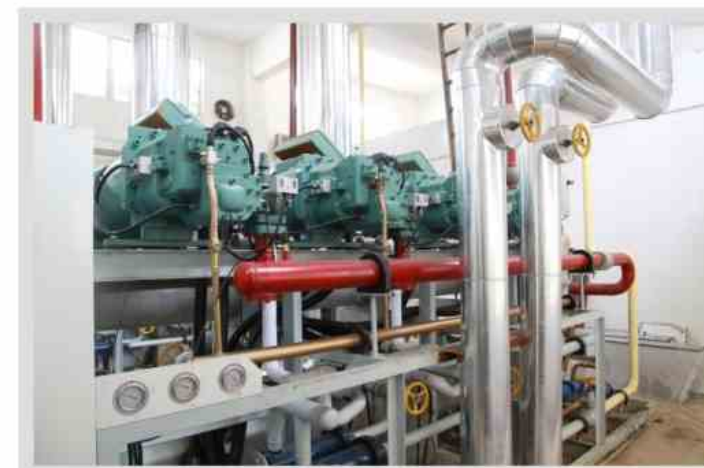
单级低温螺杆并联机组系统
