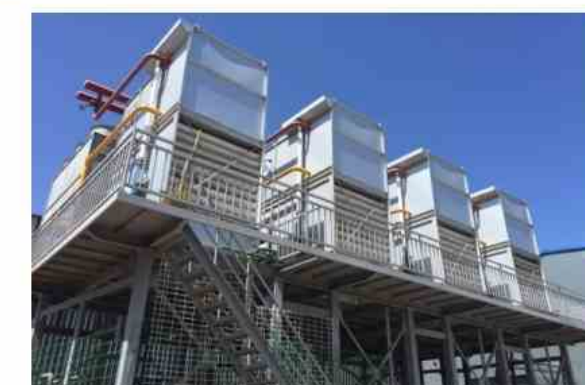
蒸发式冷凝器 Evaporative Condenser
