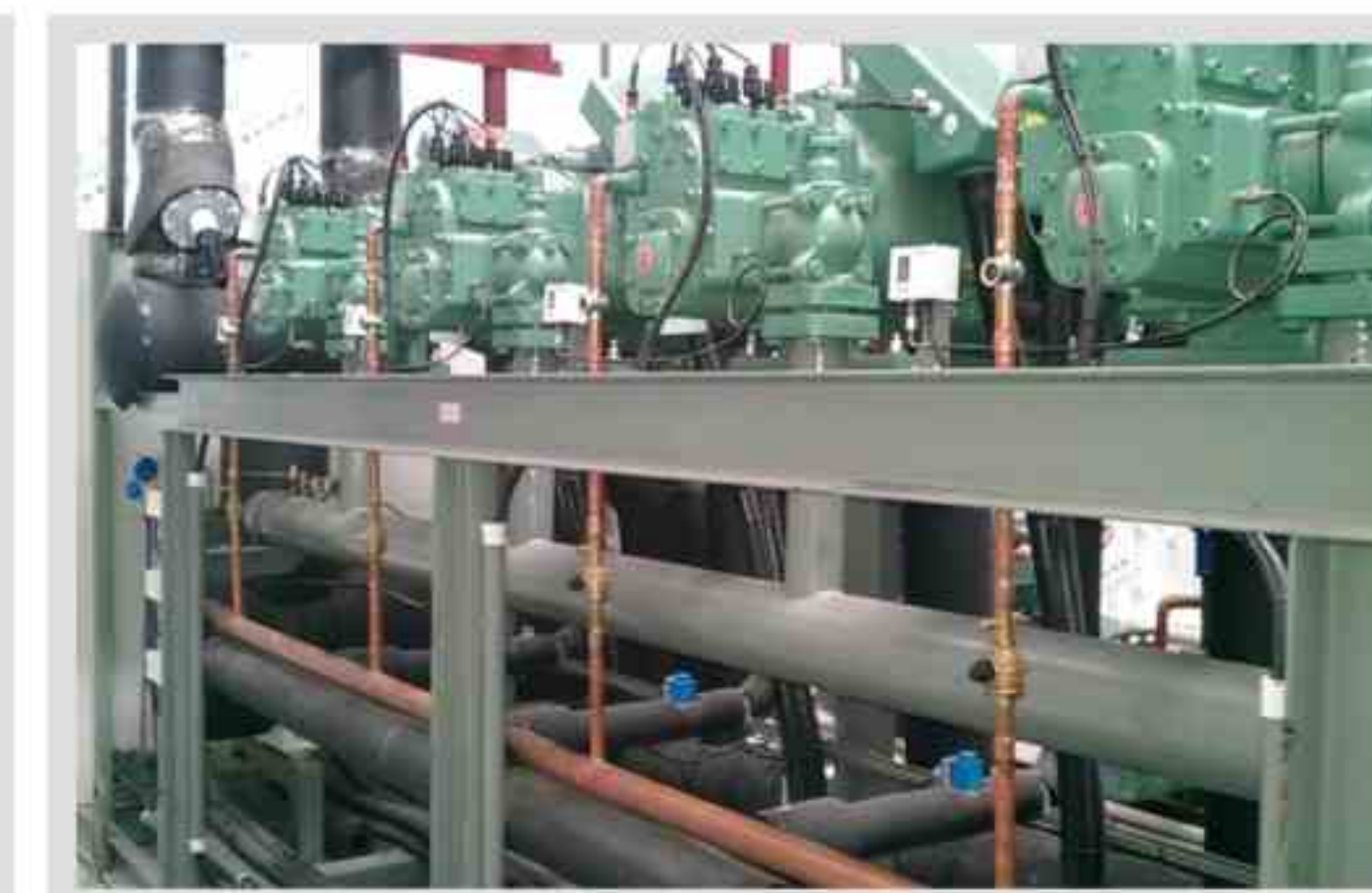
单级低温螺杆并联机组系统
