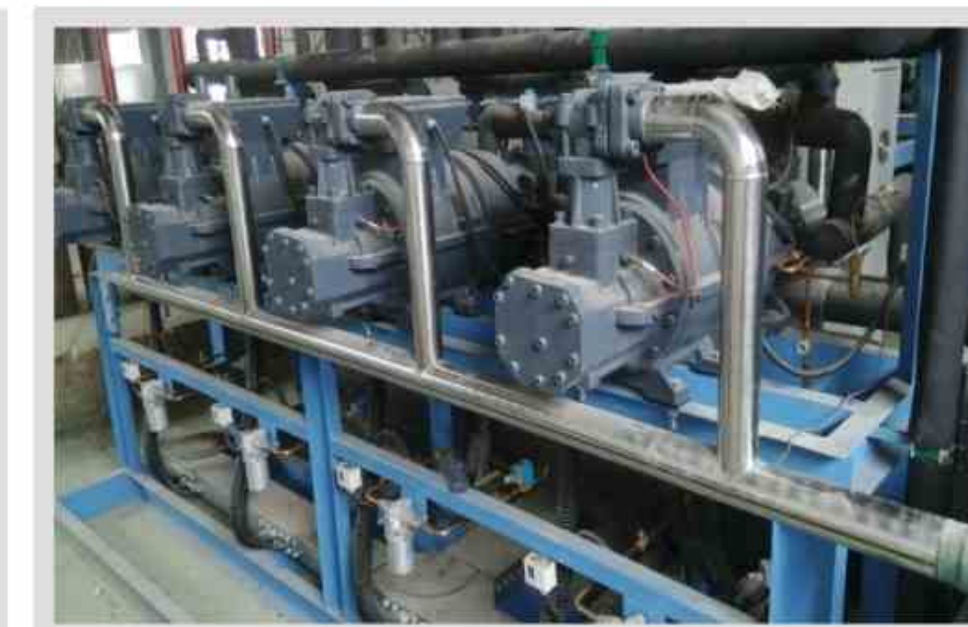
单机双级低温螺杆并联机组
